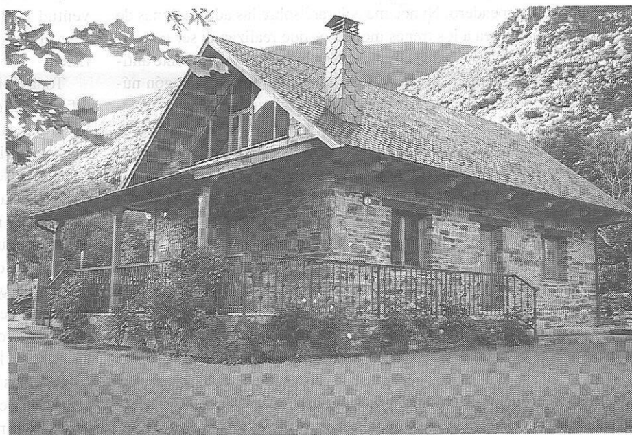
En edificios de nueva planta el primer premio ha sido para la Casa rural O Salgueiro de Burbia
